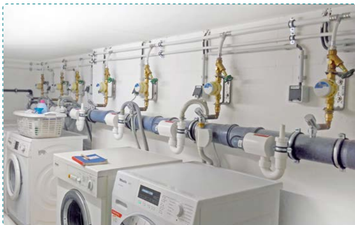
Darstellung der Waschmaschinenanschlüsse
